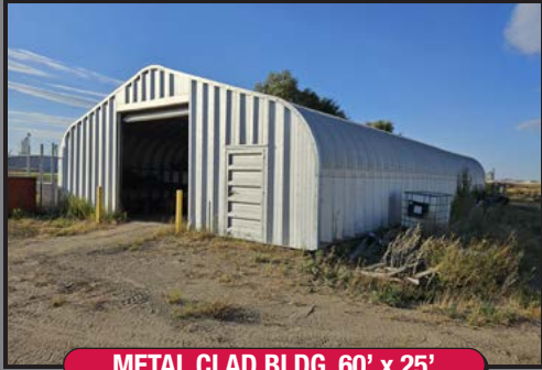
METAL CLAD BLDG. 60' x 25'
